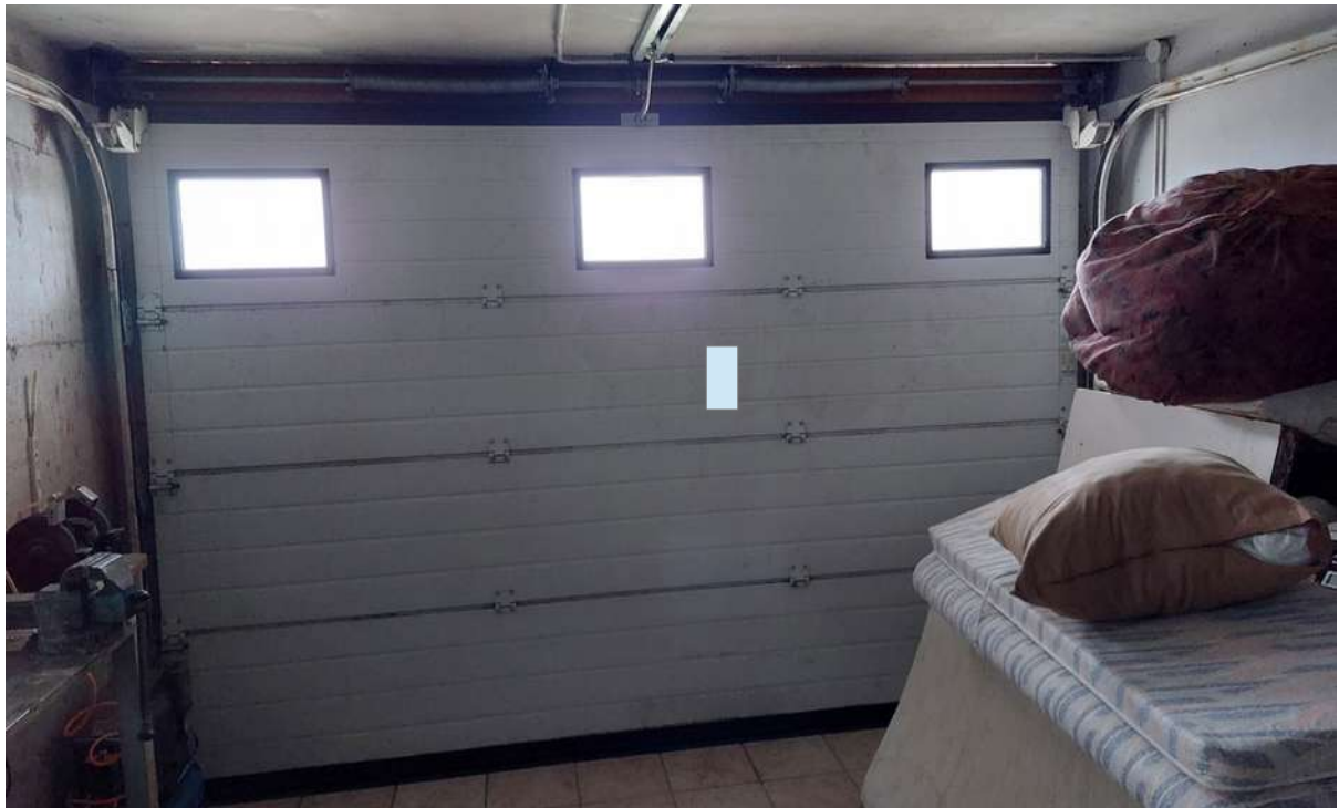
ingresso carrabile autorimessa
